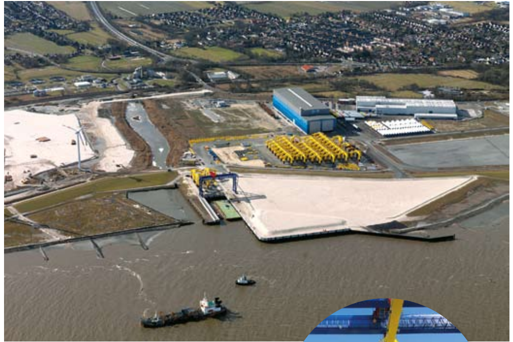
Cuxhaven aus der Luft: Links warten die Bard-Gründungsstrukturen auf Abholung, rechts die Baustelle der Strabag. Links hinten liegt die Fertigungshalle der Ambau GmbH.
